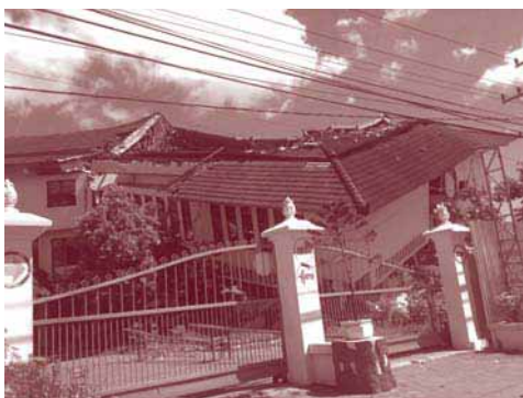
Gambar 4.2 Bangunan roboh akibat gempa
