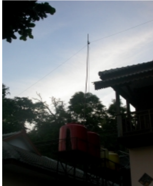
Antenna III – Panjangnya 79,5 meter Feed point 10 meter
