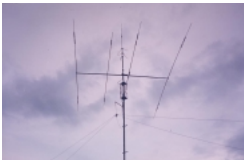
Antena Tahun 1999: 14, 21, 28 Mhz CN43DXX 7, 3,8 Mhz Dipole Inverted V.
